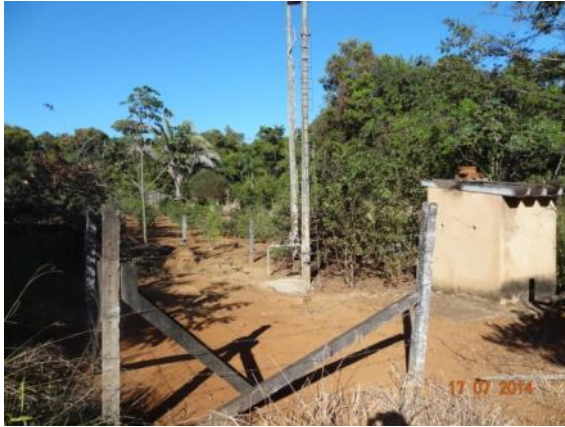
Foto 1 – Poço sem identificação
