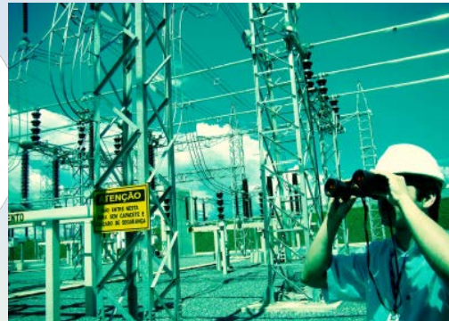
Energia elétrica - Convênio com a ANEEL
