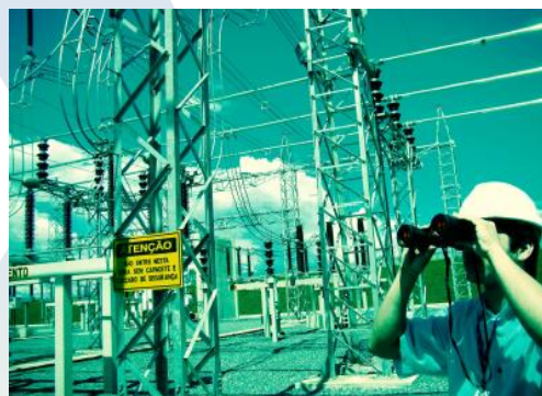
Energia elétrica - Convênio com a ANEEL
