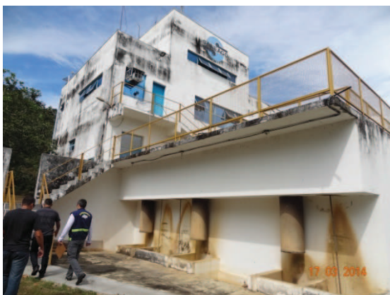
Foto 01 – Pintura reformada em 2013.
