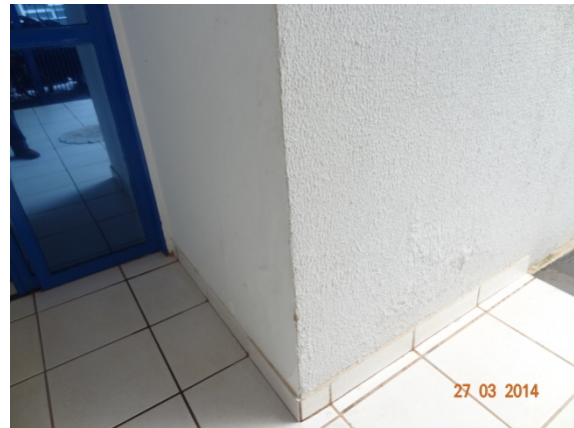
Foto 2 - Revestimento e pintura recuperada.
