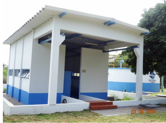
Foto 2: EEAT – Revestimento recuperado
