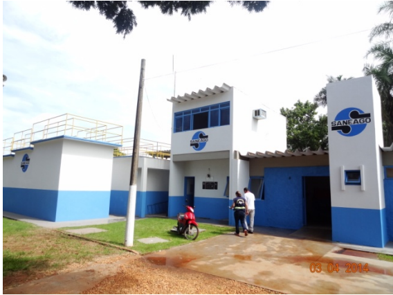
Foto 1: ETA – Recuperado Pintura, Infiltrações e Eflorescência
