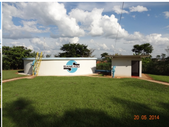
Foto 2 – Reservatório ETA totalmente restaurado
