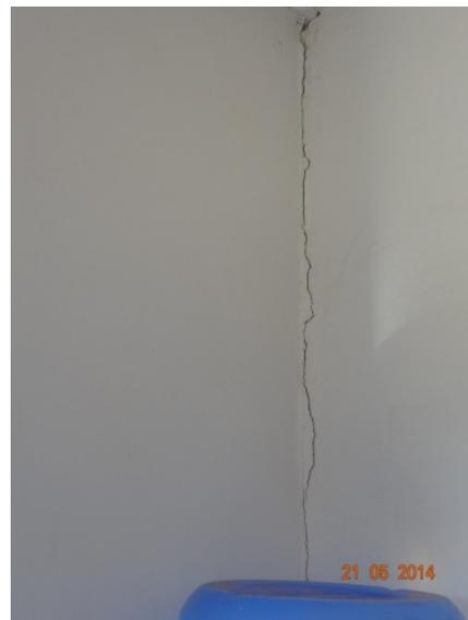
**Foto 2** – Presença de Trincas (interna).
