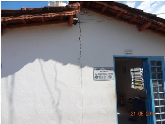
**Foto 1** – Presença de Trincas (externa).
