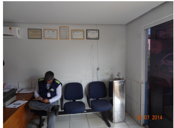
Foto 2 – Parede interna reformada
