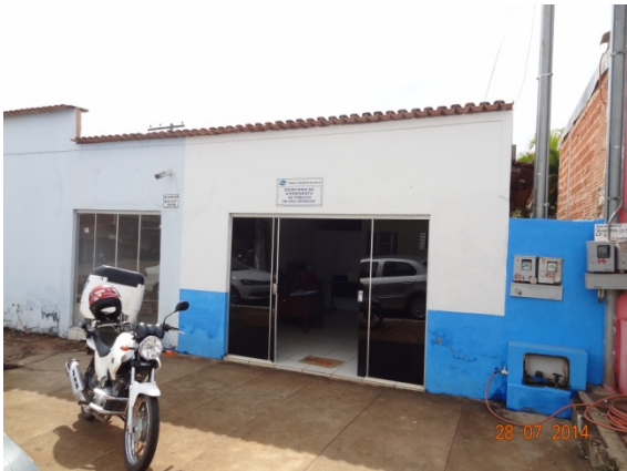
Foto 1 – Parede externa reformada
