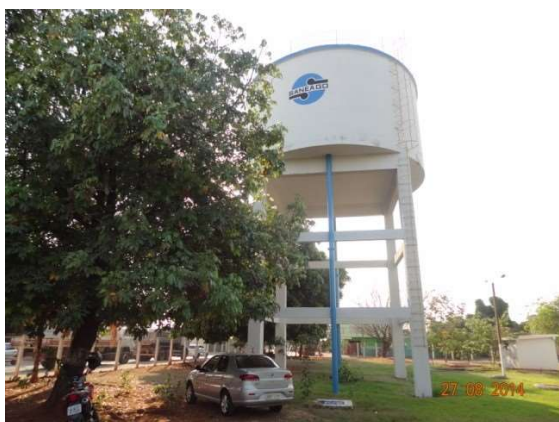
Foto 1 – Reservatório com pintura nova
