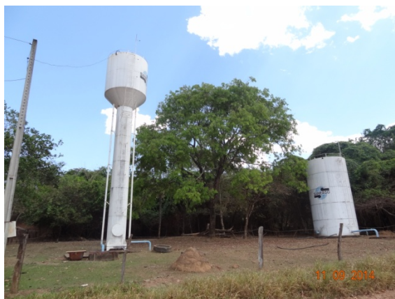
Foto 3 – Ausência de guarda-corpo
