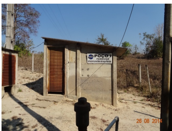
Foto 1 – Poço 01 em funcionamento
