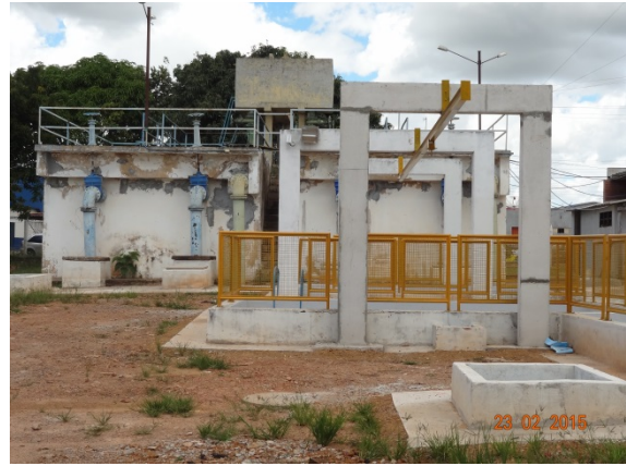
Foto 4 – Filtro da ETA
