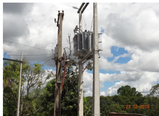
Foto 2 – Novo transformador
