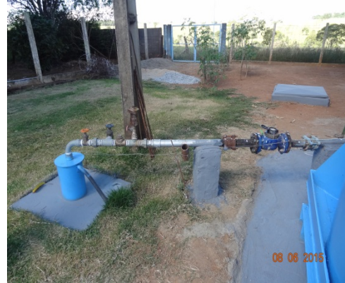
Foto 2 – Poço de Ordália
