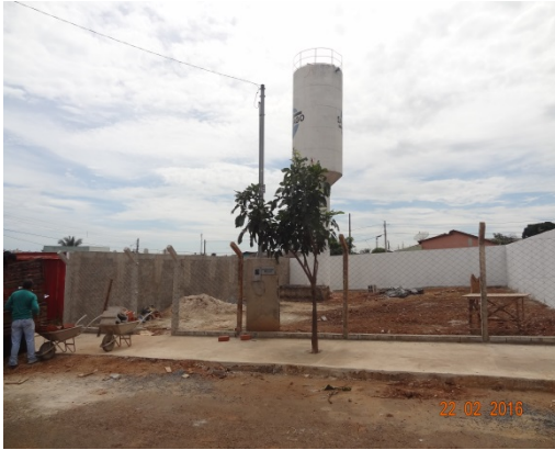
Foto 1 – C.R. Florença com cerca de proteção
