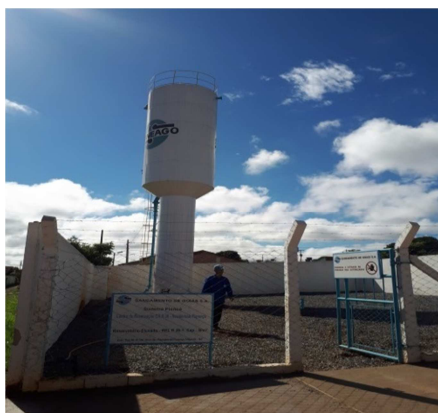
Foto 1 – REL CR Florença com cerca e portão.
