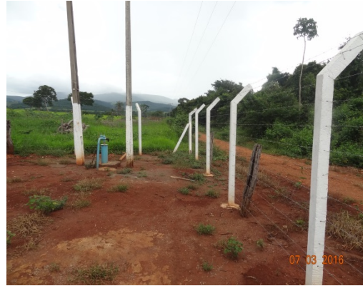
Foto 2 –Poço 07 com cerca de proteção
