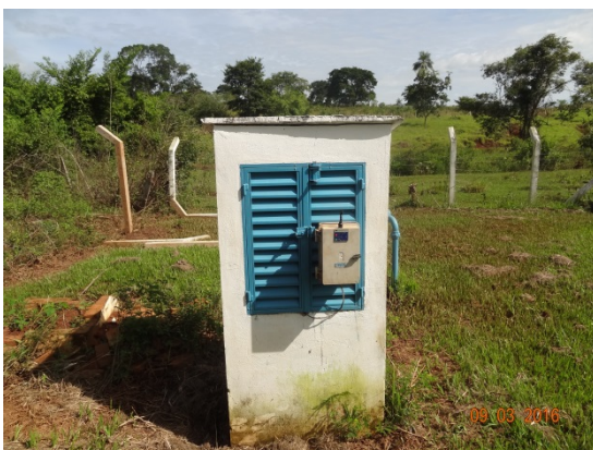
Foto 5 – Poço 01 abrigo recuperado
