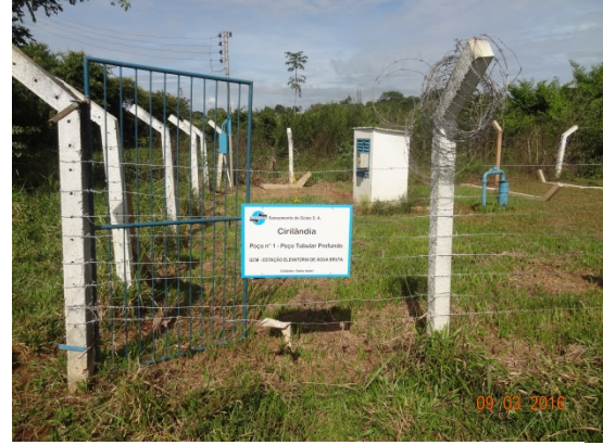
Foto 2 – Poço 01 com portão
