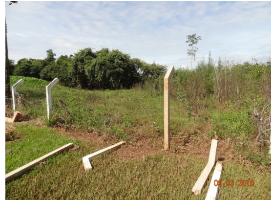
Foto 8 – Poço 01 com cerca danificada
