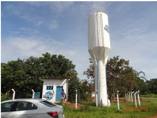
Foto 3 – Reservatório R1 com portão
