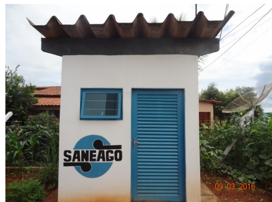
Foto 6 – Reservatório R1 com portão
