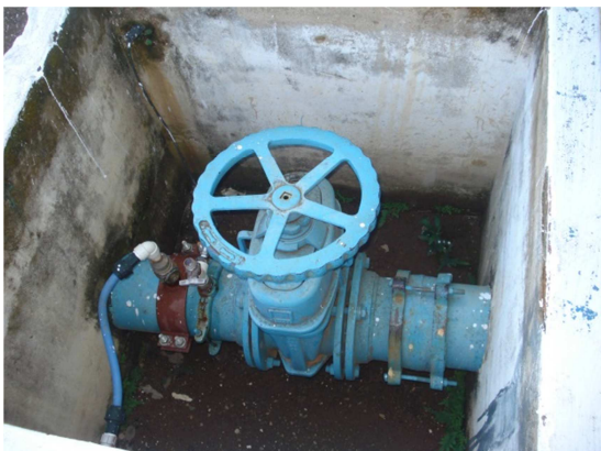
Foto 3 – Corrigido vazamento no registro de saída do REL da ETA.
