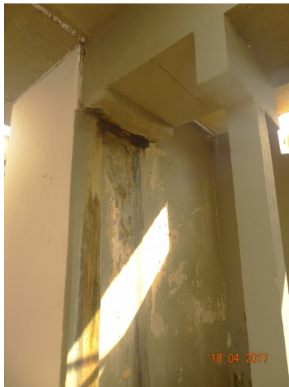
Foto 1 - Vazamento na calha Parshall reparado.
