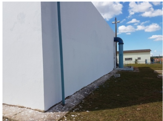
Foto 2 – RAP Escritório - Reparadas infiltrações e pinturas desgastadas
