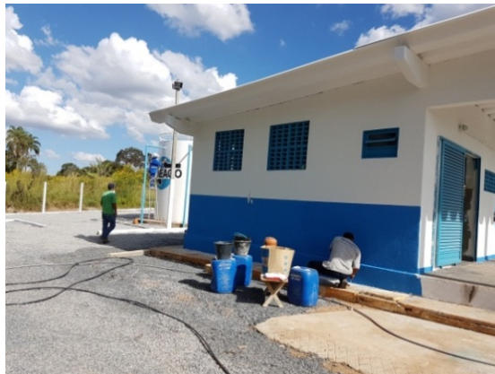
Foto 3 – RAP caixa reunião - Jardim das Paineiras - Reparado revestimento no abrigo de cloração (interno e externo)
