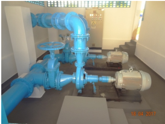
Foto 1 – RAP caixa reunião - Jardim das Paineiras - Reparado vazamento bombas
