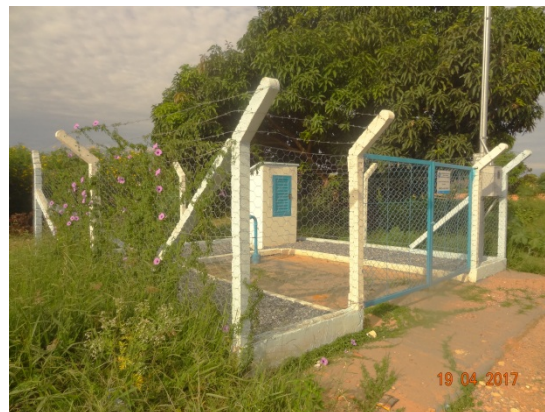
Foto 4 - Poço PMO 05 - Portão Instalado
