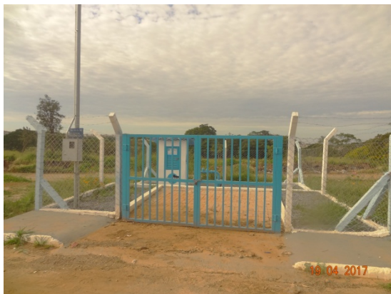
Foto 3 – Poço PMO 04 - Cerca recuperada
