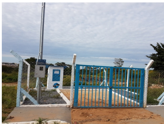
Foto 5 – Poço PMO 05 - Pintura recuperada
