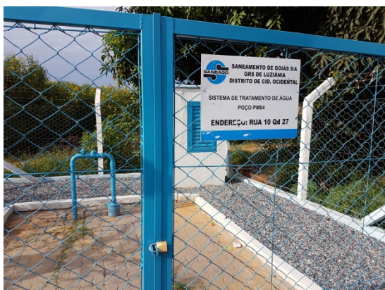
Foto 1 – Poço PMO 05 - Placa identificação instalada
