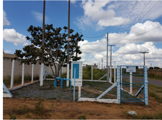
Foto 4 – Muro e/ou cerca recuperados
