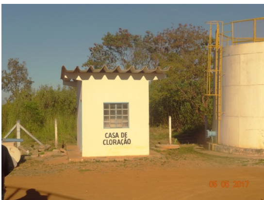
Foto 3 – Sistema de desinfecção
