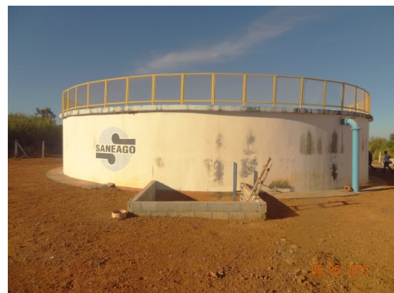
Foto 4 – Reservatório Semi-enterrado de 1.000 m 3
