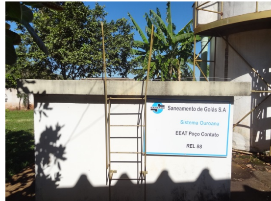
Foto 6 – Escada de inspeção soldada
