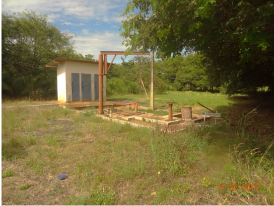
Foto 1 – ETE necessitando de manutenção na área
