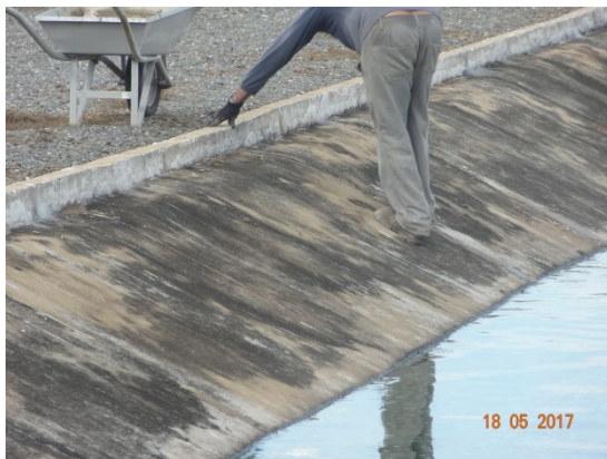
Foto 1 – Manutenção preventiva nos taludes das lagoas
