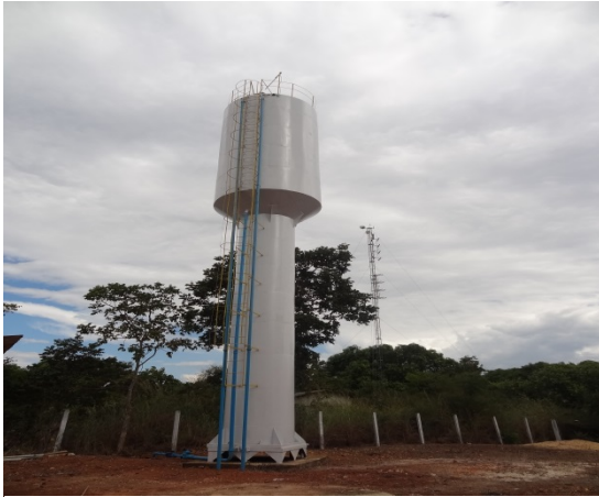
Foto 1 – REL com guarda-corpo.
