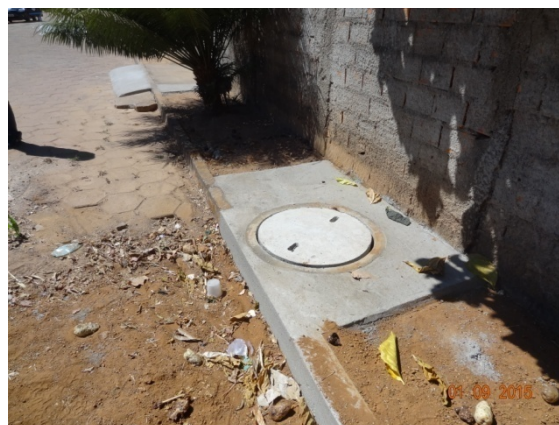
Foto 2 – Instalação de registro de descarga
