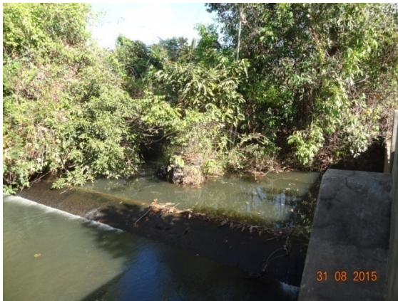
Foto 1 – Captação superficial – Córrego do Ouro
