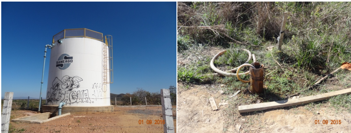
Foto 3 – Reservatório de 200 m 3 Foto 4 – Poço a ser interligado
