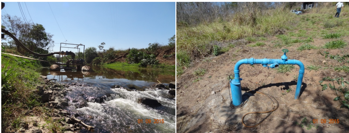
Foto 1 – Captação superficial Foto 2 – Poço tubular profundo reserva
