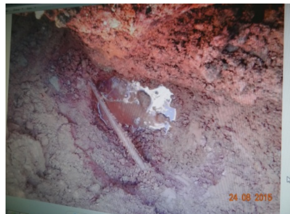
Foto 4 – Reparo de vazamento
