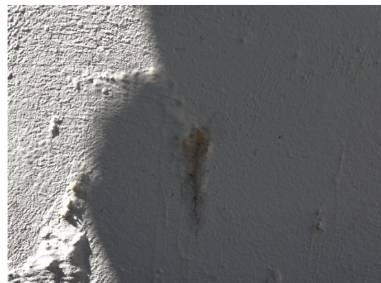
Foto 01 e 02 - Infiltrações na ETA
