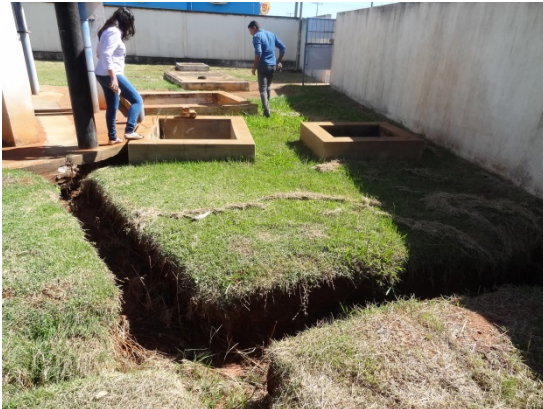
Foto 3 e 4– Erosão na base de sustentação do REL
