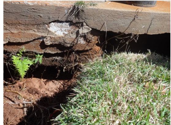
Foto 3 e 4– Erosão na base de sustentação do REL
