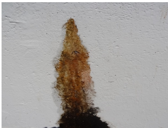
Foto 01 e 02 - Infiltrações na ETA
