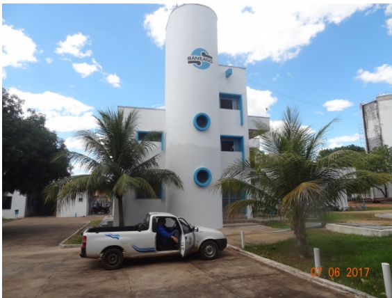
Foto 1 – Edificações da ETA com pintura renovada.
