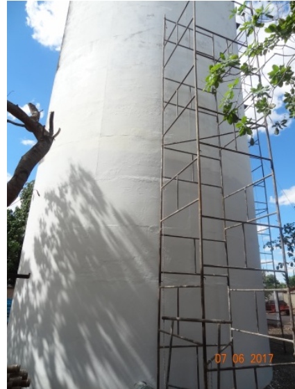
Foto 2 – REL da ETA com pintura renovada.
