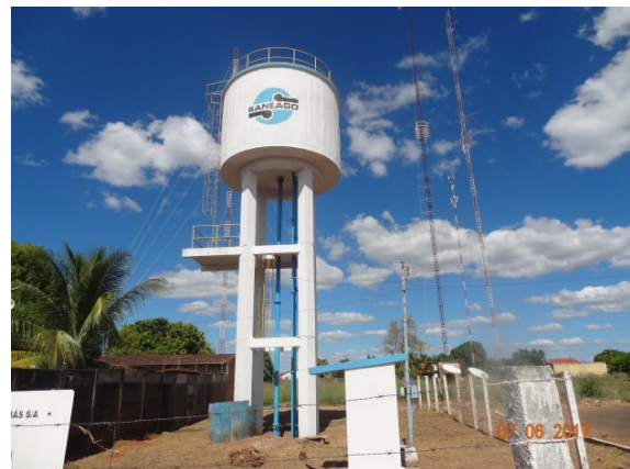
Foto 4 – REL Morada do Araguaia com guarda-corpos instalados na escada.
