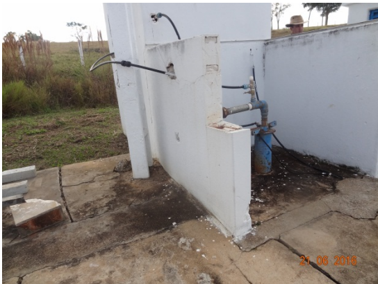
Foto 1 – Casa de cloração com pintura e revestimentos recuperados.
