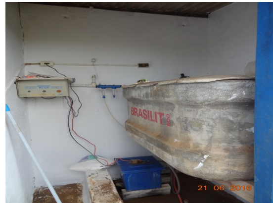
Foto 2 – Casa de cloração com pintura e revestimentos recuperados.
