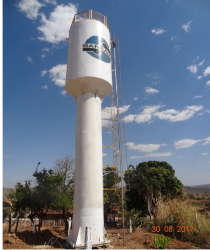
Foto 3 – REL 50 m 3 novo e instalado.
