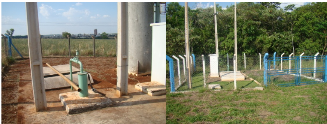
Foto 1 –Novo Poço 2 perfurado Foto 2 – Novo Poço 6 perfurado
