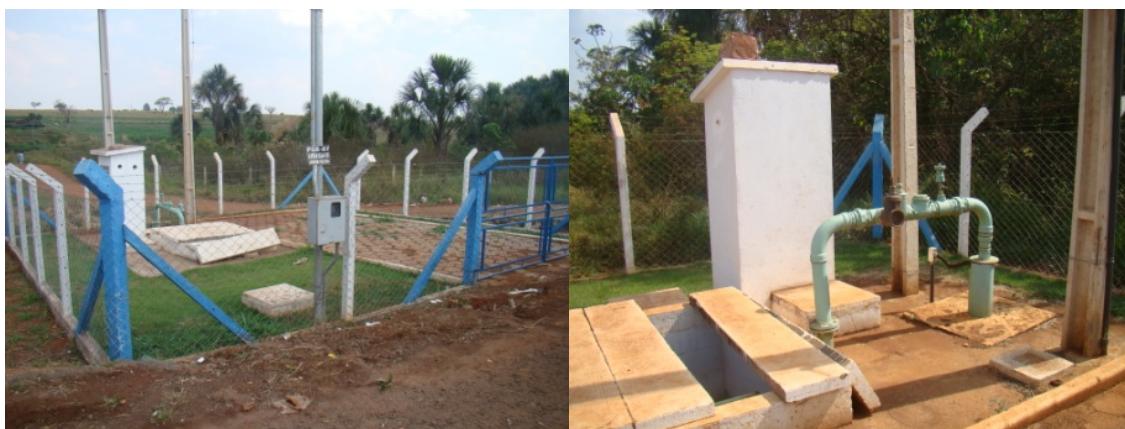
Foto 3 –Novo Poço 7 perfurado Foto 4 – Novo Poço 8 perfurado
