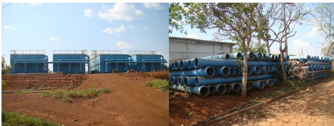
Foto 5 - ETA modular sendo montada Foto 6 - Materiais para adutoras
