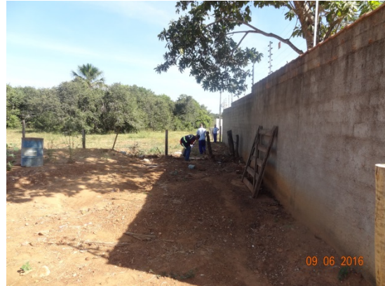
Foto 2 – Acesso obstruído com cerca e muro.
