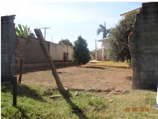
Foto 3 – Acesso obstruído com construção civil.
