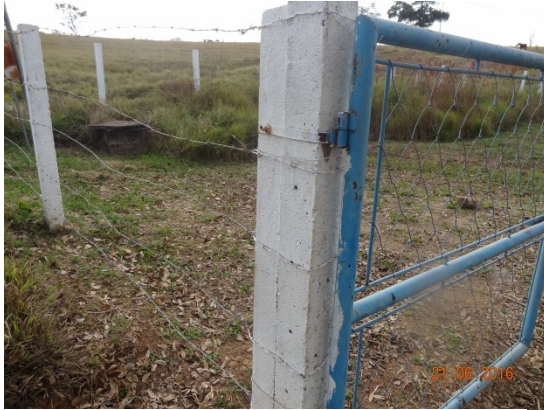
Foto 1 – Cerca recuperada no poço 1
