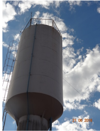
Foto 2 – REL com guarda-corpo
