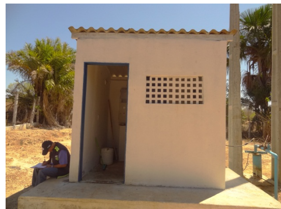
Foto 2 – Casa de Cloração Poço 01
