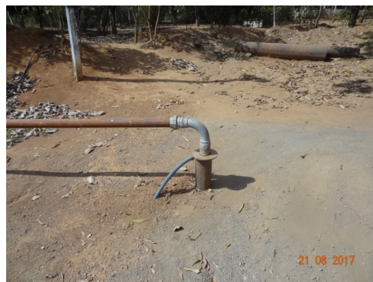
Foto 2 – Poço da captação
