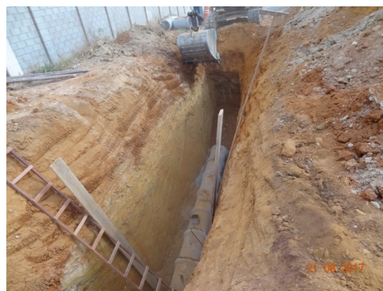
Foto 4 – Escavação para implantação de rede adutora água pluvial
