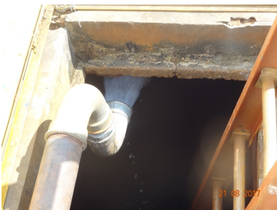
Foto 3 – Poço de sucção da captação
