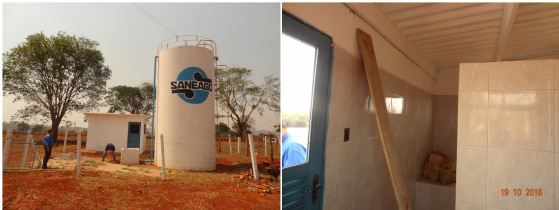
Foto 1 – Casa do clorador com pintura recuperada Foto 2 – Casa do clorador reformada recuperada
