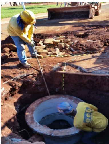
Foto 9 - Execução de poço de visita
