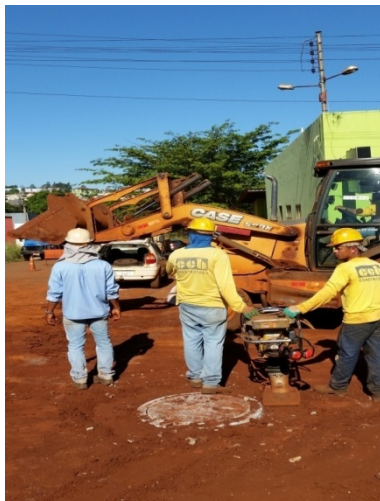
Foto 3 –Recuperação de asfalto
