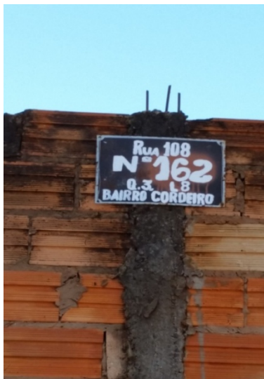
Foto 1 –Obras Setor Cordeiro
