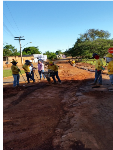
Foto 12 – Recuperação de asfalto
