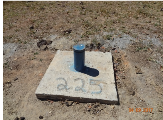
Foto 2 – Poço PGD – 225 novo.
