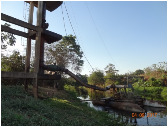
Foto 5 – Captação Rio Passa Três.
