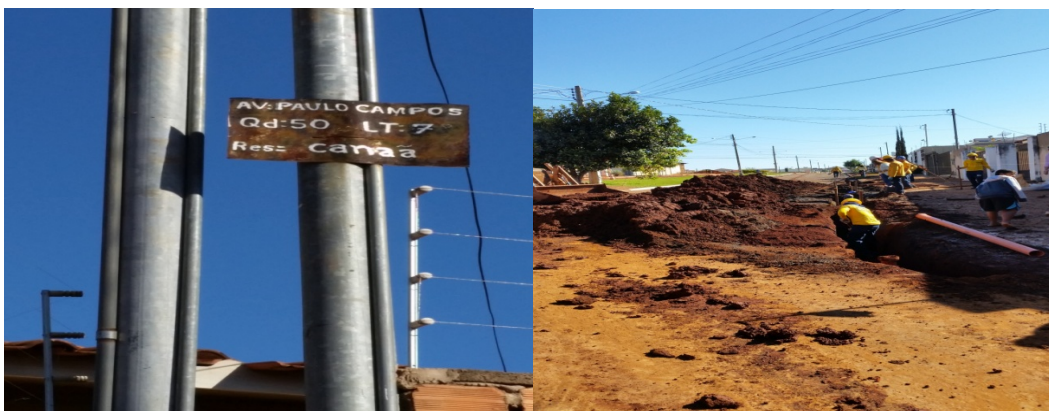
Foto 18 -Ampliação das redes coletoras de esgoto
