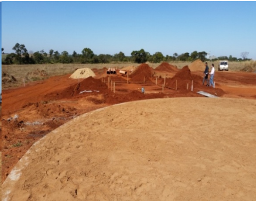
Foto 12 –Fundação caixa de manobra
