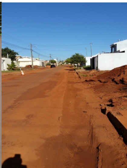
Foto 16 -Ampliação das redes coletoras de esgoto
