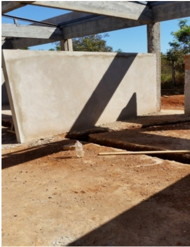
Foto 5 - Interior - Casa de Química
