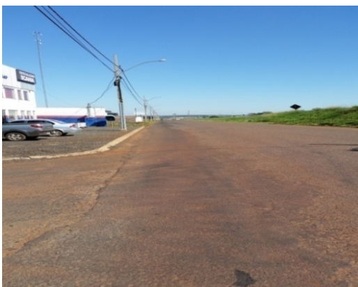
Foto 9 - Adutora ETA / CR Aeroporto
