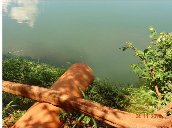
Foto 2 – By pass da EEE IV (25/11/2016)
