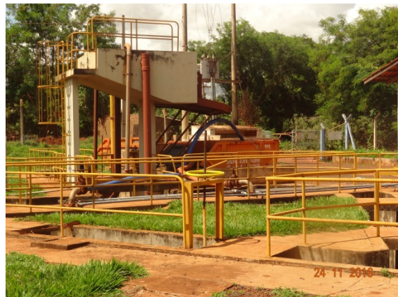
Foto 4 – Limpeza do desarenador automatizada
