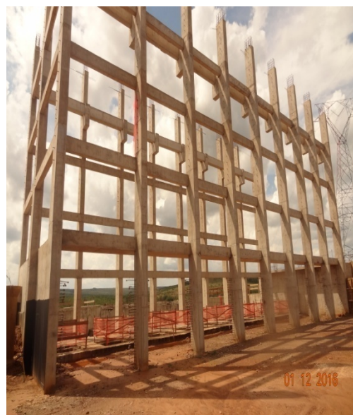
Foto 4 -Estruturas já construídas na EEAB Corumbá-1º e 02/12
