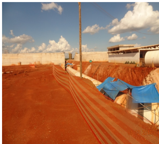
Foto 20 - Interligações área de Tanques - 1º e 2/12
