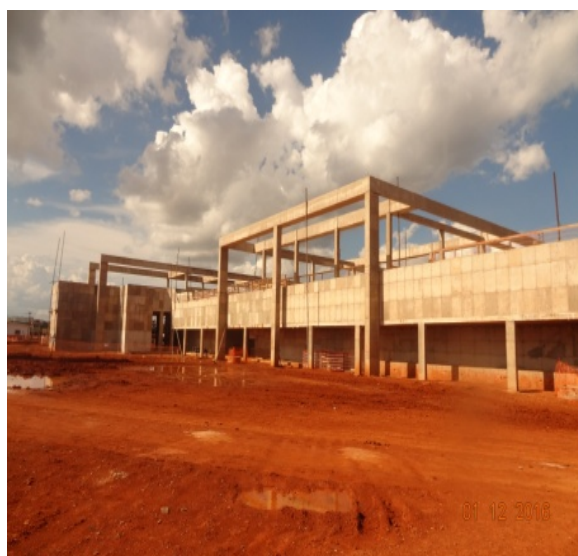
Foto 18 - ETA - Obras área Tanques de Tratamento - 1º e 2/12
