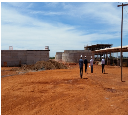
Foto 19 - Obras área Tanques de Tratamento - 31/03 e 1º/04
