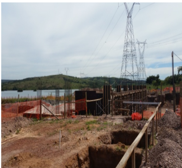
Foto 3 - Escavações na EEAB Corumbá-31/03 e 1º/04
