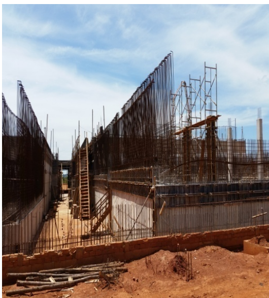
Foto 17 - ETA - Obras área Tanques de Tratamento - 31/03 e 1º/04
