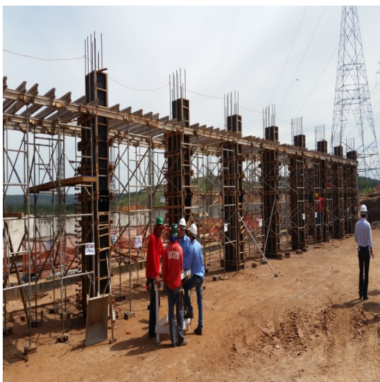
Foto 3 -Início amarração estruturas na EEAB Corumbá-31/03 e 1º/04
