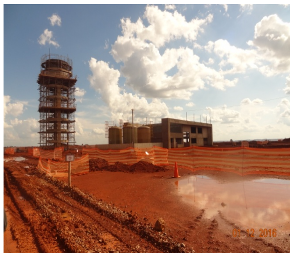
Foto 16 - ETA - Obras área Casa de Química - 1º e 2/12
