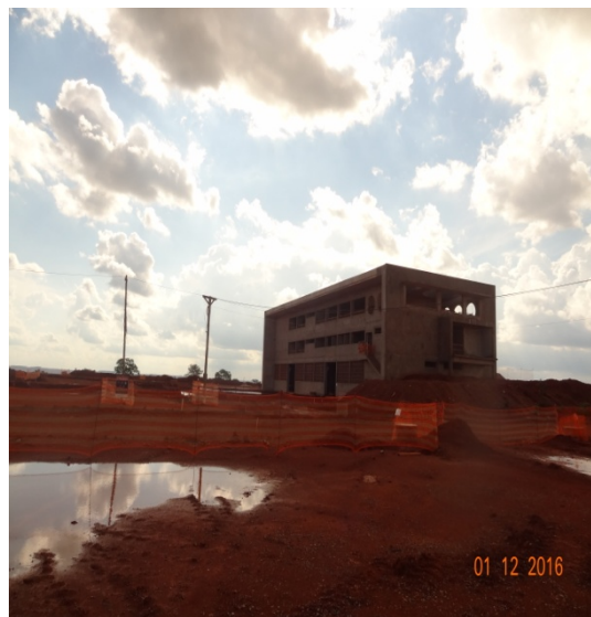
Foto 14 - ETA -Prédio Administração - 1º e 2/12
