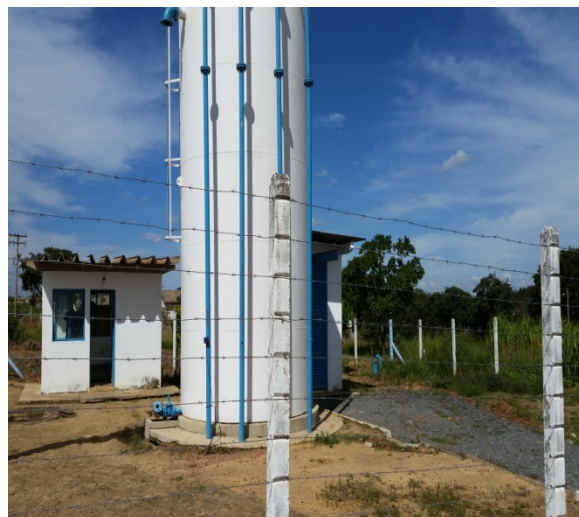
Foto 10 - Poço 16 - Cx. de reunião PED IV (13 m3/h)
