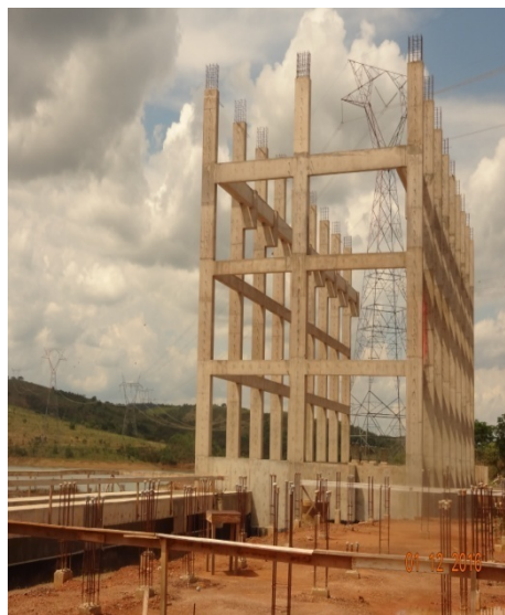
Foto 4 -Estruturas já construídas na EEAB Corumbá-1º e 02/12
