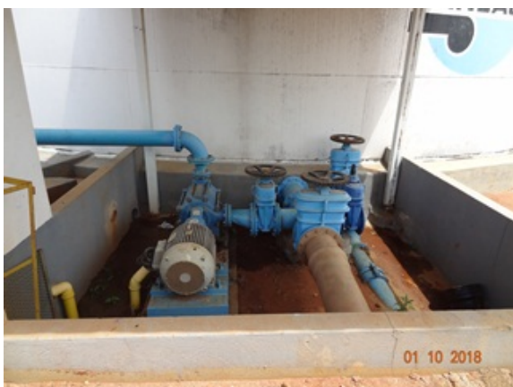
Foto 5 - Melhoria da EEAT Sudeste
