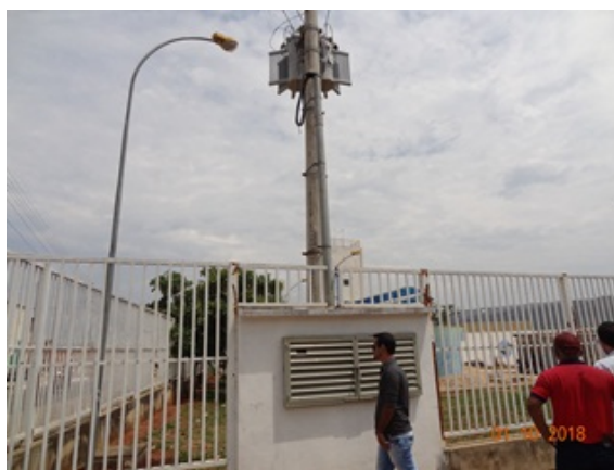
Foto 4 - Ampliação da subestação
