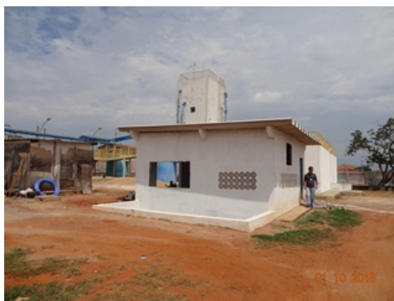
Foto 6 - Ampliação da EEAT Santa Bárbara
