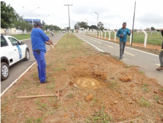
Foto 3 - Local onde será instalada a VRP.
