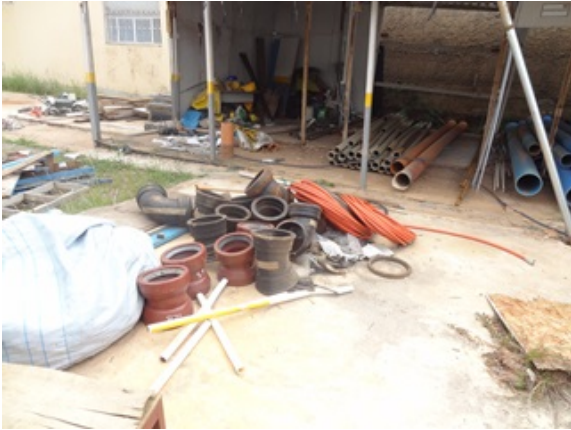
Foto 1 - Materiais destinados para o término das obras da nova adutora (localizados na área da ETA).
