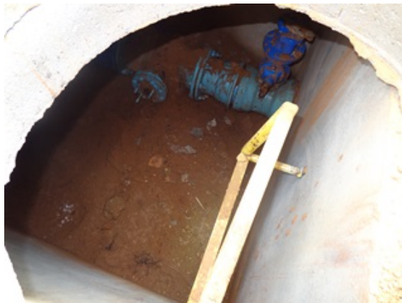
Foto 4 - Local onde será instalada a VRP.
